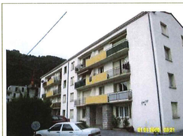
Photo n°1.: Angle Sud-Est de l'immeuble
